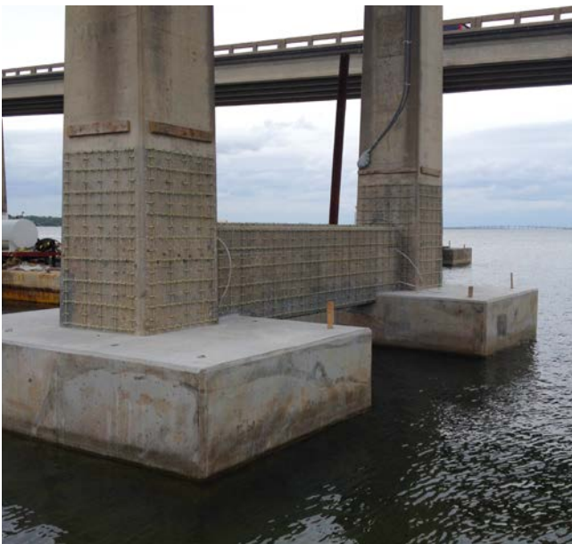
Sanierung von Brückenstützen im Salzwasser Florida, USA
