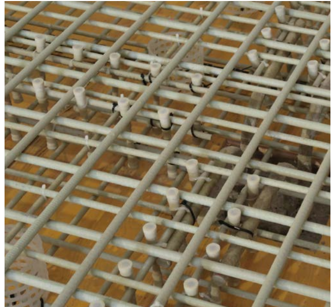
Bodenplatten- und Durchstanzbewehrung Fusionsreaktor-Forschungsanlage Tokamak in Prag, Tschechische Republik
