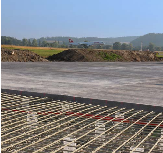
Neubau eines Rollwegs Flughafen Zürich, Schweiz
