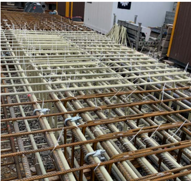
Schlitzwandbewehrung Autobahneinhausung Schwamendingen, Schweiz
