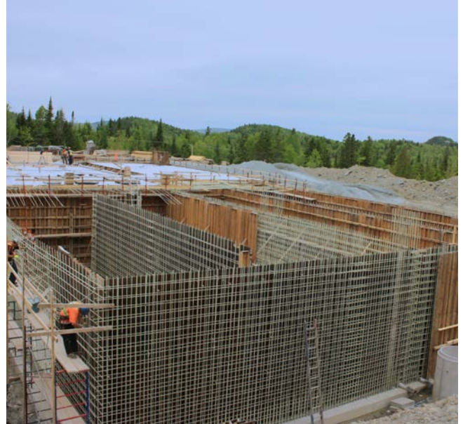
Tanks für Kläranlage, Wand- und Bodenplattenbewehrung Thetford Mines, Québec, Kanada
