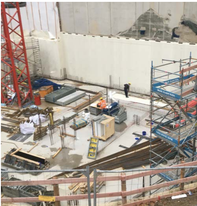
SECUFLEX® als Zusatzmaßnahme eines WU-Bauwerks
