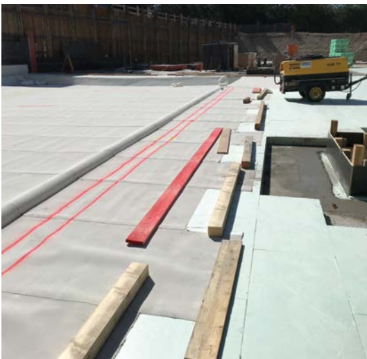
Unterlegholz zur Ablage von Bewehrung
