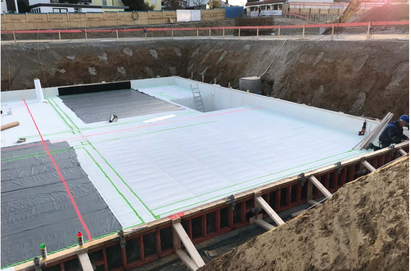
Verlegung unter Bodenplatte mit einlagiger PE-Folie
