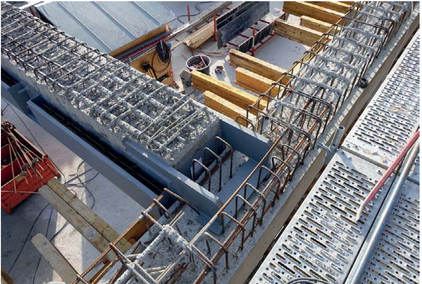
A – Fugenfülltechnik mit schwindarmem Mörtel
