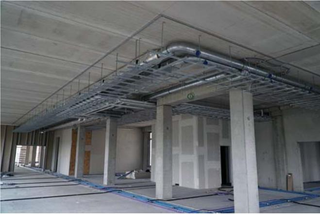
*Absenkung der baulichen Deckenhöhe in ausgewählten Abschnitten zur einfacheren (kollisionsfreien) Verlegung von Unterdeckeninstallationen – Bürogebäude Campus Loddenheim, Deutschland*
