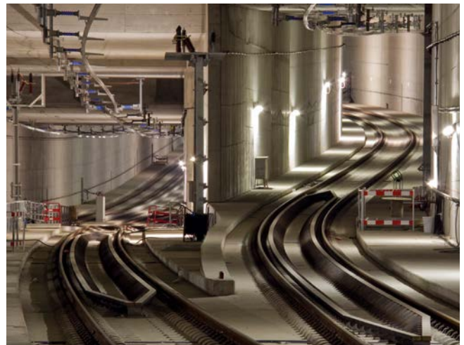
City-Tunnel Leipzig, Deutschland
