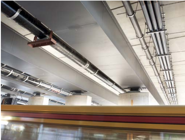
Spandauer-Damm-Brücke in Berlin, Deutschland
