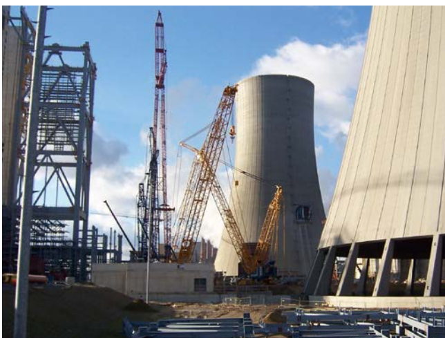
Kraftwerk Neurath in Grevenbroich, Deutschland
