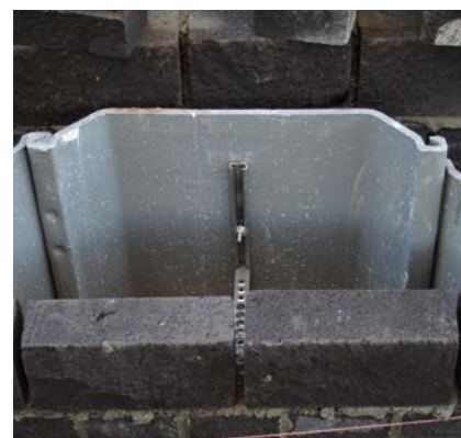
Anschluss von Verblendmauerwerk an Spundwand
