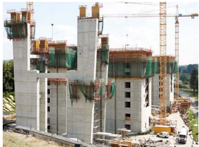
Schiffshebewerk Niederfinow, Deutschland
